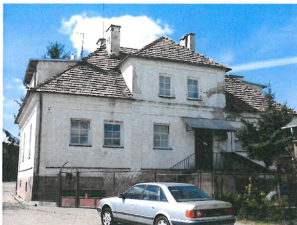
Fot. 8. Budynek dawnej łaźni Miejskiej
