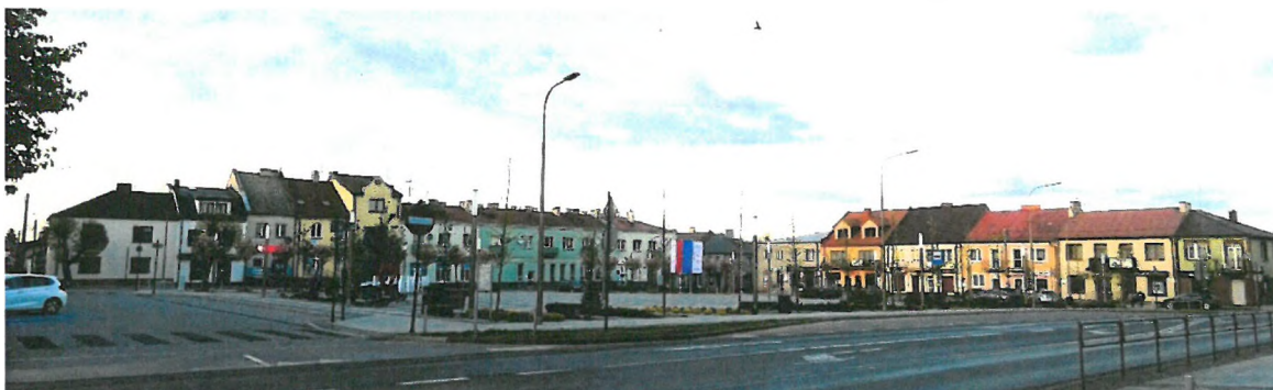
Fot. 1. Widok na północno-wschodnią pierzeję Rynku
