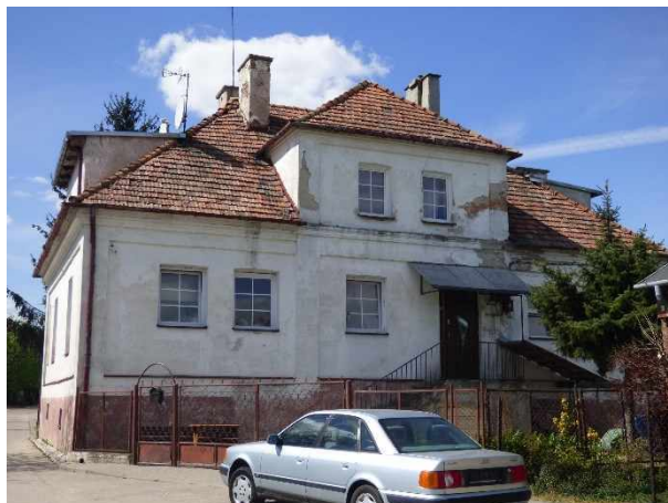
Fot. 8. Budynek dawnej Łaźni Miejskiej
